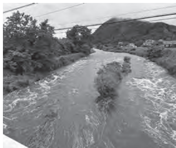
古町橋・増水の様子
