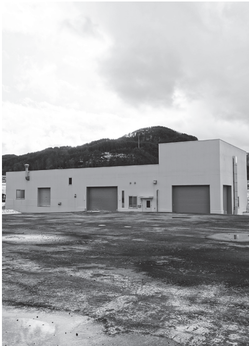
汚泥再生処理センター(立岩)
