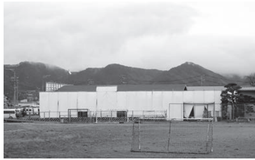
工事が進む古町コミュニティ施設
