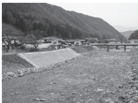
復旧した和田上組の堤防
