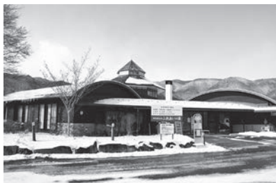
ポンプ工事をするふれあいの湯
